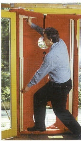
Abb. 8: Leichtes Einsetzen des Rahmens mit Nylonplane
